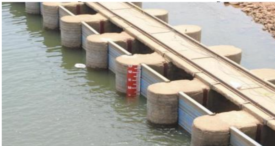
Joonis 1. Statsionaarne mõõdulatt (Paisutuskõrguse mõõtmise juhend 2012)
